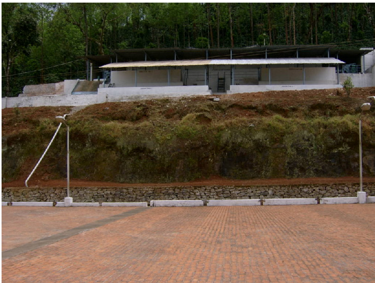
Foto 4 -Vista geral de uma das instalações de preparo da Índia
